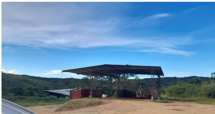
Figuras 8, 9 e 10: Fotos da estação de transbordo de Embu Guaçu.
